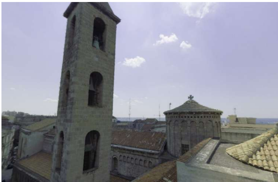
Figura 33 - Vista significativa ottenibili ad "occhio nudo" dal piano copertura dell'edificio pastorale
