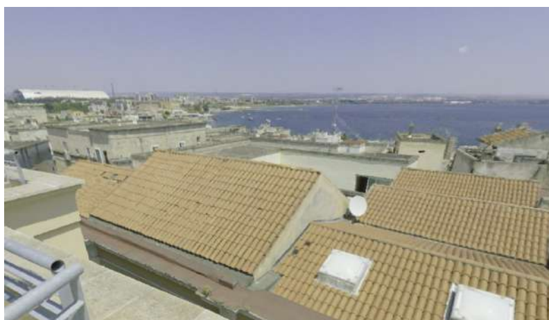
Figura 32 - Vista significativa ottenibili ad "occhio nudo" dal piano copertura dell'edificio pastorale
